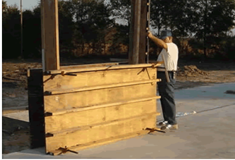
شكل (٢-١٩٩) شدة خشبية حديثة وجود دعائم جانبية لتقويتها
