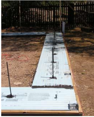
شكل (٢-٣٦٨) رفع الاساس عن سطح الأرض مع وضع عازل للرطوبة
