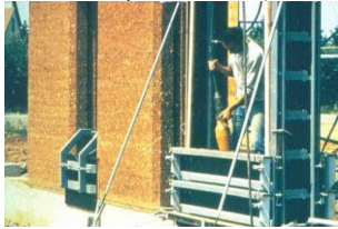
شكل (٢-٢١٤) فرنسا - منزل باستخدام الوحدات سابقة الدك- شدة معدنية لعمل الحائط
