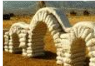
شكل (٢-٢٧١) عمل تكوينات من العقود من الأكياس
