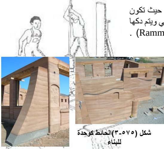
شكل (٣-٥٧٤) اسكتش خطوات العمل الحائط كوحدة للبناء
