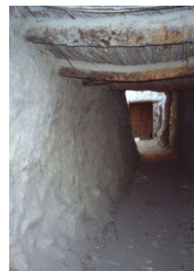
شكل (١-٧٩) استخدام النخل كمرات لحمل السقف في الممرات
