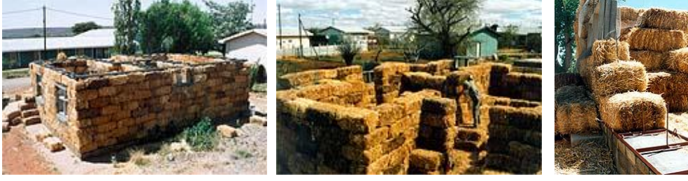
شكل (٢-٤٩٢) الشكل النهائي للحوائط بعد تثبيت الإطار العلوي
