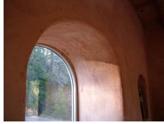
شكل (٢-٤٣٦) فتحات شبابيك ذات تشكيل منحنى قبل وبعد وضع الطبقة النهائية
