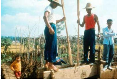
شكل (٣-٥٥٤) بناء حائط بالدك - الصين
