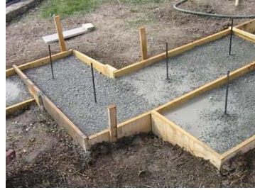
شكل (٢-٣٧٧) الشكل النهائي بعد صب الخرسانة مثبت بها قضبان معدنية
