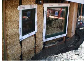
شكل (٢-٤١٤) الحائط الخارجي قبل التشطيب
