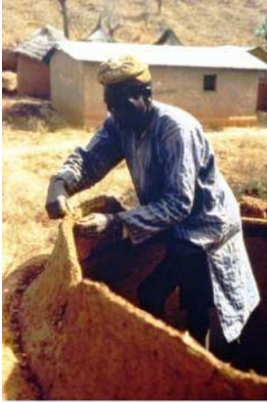
شكل (١٧٠-٢) طريقة البناء بالتشكيل الترابي نيجيريا
