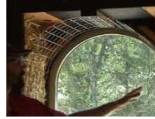
شكل (٢-٤٣٦) فتحات شبابيك ذات تشكيل منحنى قبل وبعد وضع الطبقة النهائية
