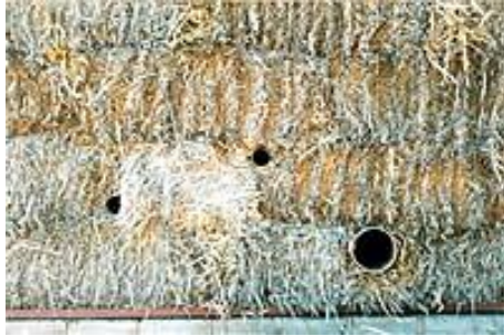
شكل (٢-٥٠٠) تحديد أماكن مواسير الصرف والتغذية
