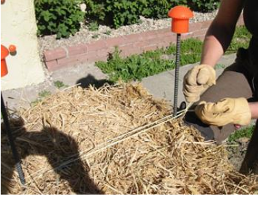
شكل (٢-٣٨٣) الحائط بعد وضع المدمك الثاني و ربط الدعامات الجانبية لتقوية للحائط
