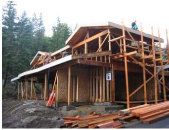
شكل (١-٤١٢) المنزل بعد إكمال الهيكل الخشبي
