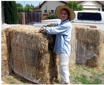
شكل (٢-٣٨٩) الحائط بعد وضع الشبك المعدني
