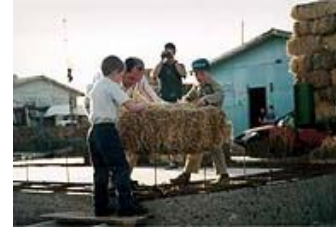
شكل (٢-٤٨٨) أول مدمك يثبت في الأساسات بمشاركة الأطفال
