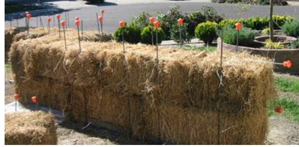
شكل (٢-٣٨٣) الحائط بعد وضع المدمك الثاني و ربط الدعامات الجانبية لتقوية للحائط
