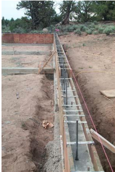
شكل (٢-٥٠٦) الأساسات بعد صب الخرسانة ووضع قضبان من الحديد
