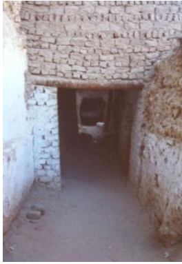
شكل (١-٨١) استخدام جذوع النخل كعتب للأبواب
