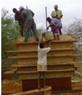
شكل (٣-٥٨٦) شدة خشبية بارتفاع الحائط مع وضع التربة يدويا
