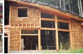
شكل (٢-٤٢٢) حوائط دائرية بعد وضع البالات داخل الهيكل الخشبي
