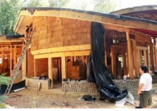
شكل (٢-٤٢٢) حوائط دائرية بعد وضع البالات داخل الهيكل الخشبي
