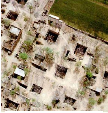
شكل (٢-١٢٨) تجمعات سكنية تحت الأرض - الصين
