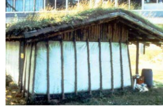
شكل (٢-٢٦٧) دعائم خشبية للأكياس مزروع السطح- ألمانيا
