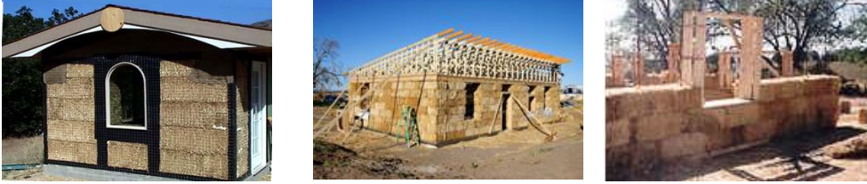
شكل (٢-٣٣٧) مباني من الداخل حوائط من بالات القش مستقيمة قبل التشطيب
