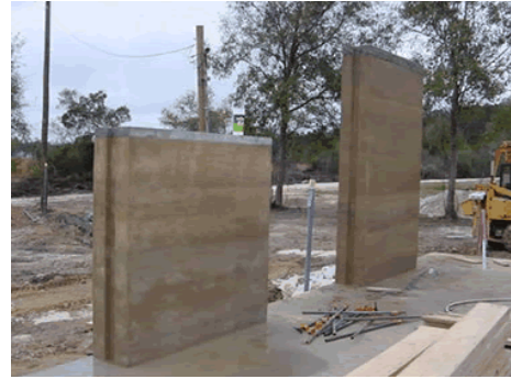
شكل (٢-٢٠٠) حائط من التربة المصدومة به فتحة باب
