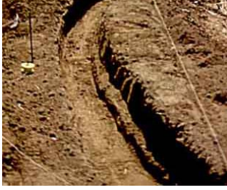
شكل (٢-٣٩٣) حفر غير عميق لوضع الأساس للحائط
