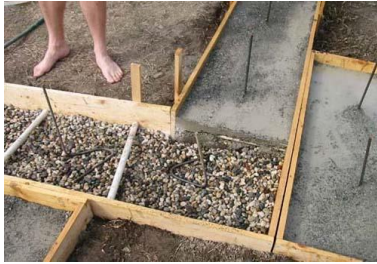
شكل (٢-٣٧٦) الأساسات يوضع بها قضبان معدنية
