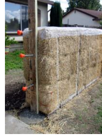
شكل (٢-٣٨٨) خطوات وضع التشطيب علي الحائط بوضع الطبقة الأولى
