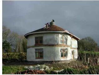
شكل (٢-٤١١) المبنى من الخارج بعد انتهاء التشطيب
