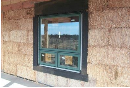
شكل (٢-٥١٢) الحائط قبل التشطيب من الخارج
