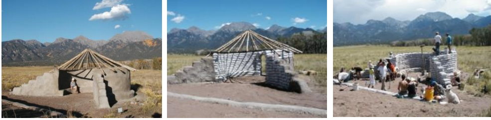
شكل (٢-٢٧٢) بناء دائري من أكياس تم ملئها بالتربة
