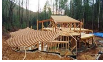
شكل (٢-٤٢٠) الهيكل الخشبي الدائري للمنزل
