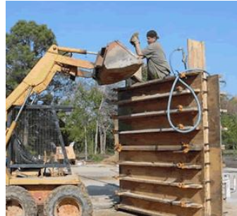
شكل (٣-٥٨٥) شدة بارتفاع الحائط مع وضع التربة باستخدام الميكنة
