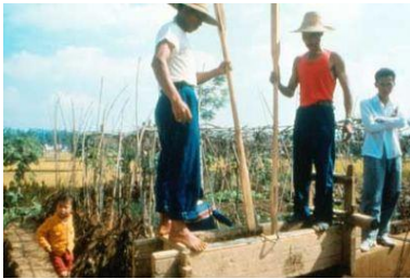
شكل (٢-١٩٠) الصين - بناء حائط بطريقة التربة المدسدة
