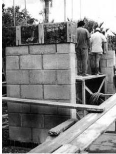
شكل (٢-١٦٦) صب الحوائط بطريقة تقليدية - نيوزيلندا
