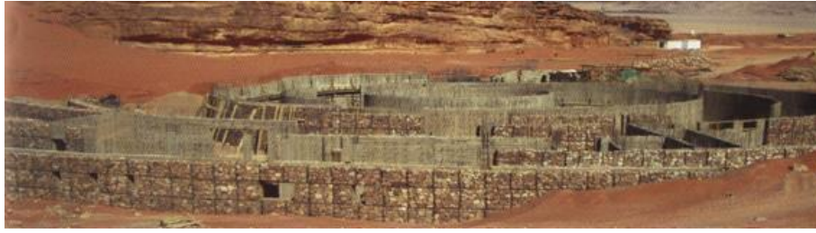
شكل (١-٧٢) النظام الإنشائي المتبع باستخدام الأحجار المجمعدة داخل قفص حديدي تتخللها الفتحات
