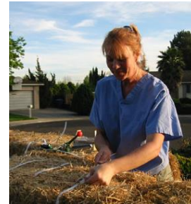
شكل (٢-٣٨٤) خيوط بلاستيكية لربط الباله تثبت في الأساس عند صبها وترتبط من أعلي
