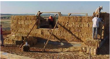
شكل (٢-٤٥٨) وضع إطار خشبي لعمل للفتحات
