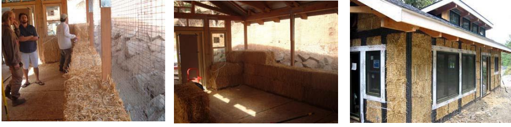
شكل (٢-٣٥٧) الإنشاء الهيكلي من الخشب للمبنى من الخارج – المبنى من الداخل والشبك المعدني مثبت بالهيكل
