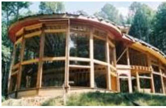
شكل (٢-٣٦١) الهيكل الخشبي الدائري قبل وضع الحوائط
