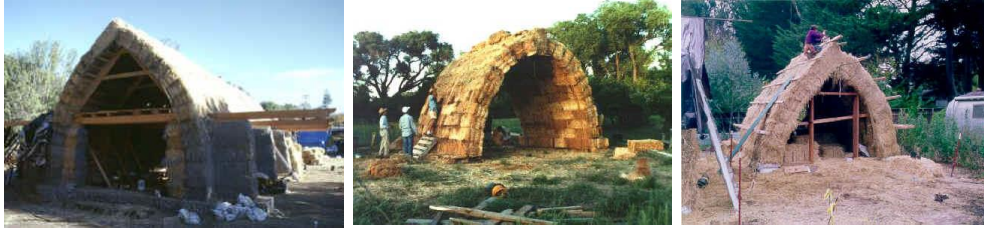
شكل (٢-٤٤٤) سقف المبني على شكل عقد
