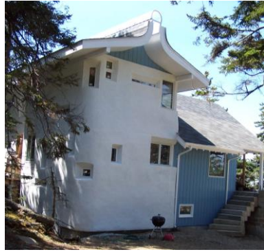
شكل (٢-٤٢٢) حوائط دائرية بعد وضع البالات داخل الهيكل الخشبي
