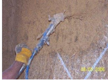
شكل (٢-٤٤٩) وضع أول طبقة تشطيب للحائط مع وجود شبك ممد عن طريق الضخ
