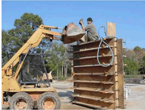
شكل (٢-٢٠١) استخدام الميكنة في وضع التربة داخل الشدة
