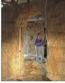
شكل (٢-٤٣٥) فتحة باب على شكل عقد
