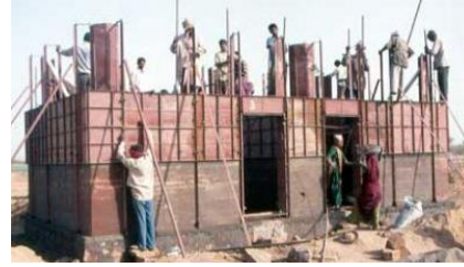
شكل (٢-٢٠٢) الهند - إنشاء مبني مستطيل
