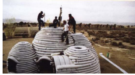
شكل (٢-٢٨١) عملية إكمال السقف
