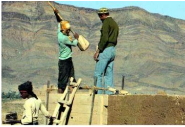
شكل (٢-١٨٩) المغرب- استخدام المدك اليدوي
