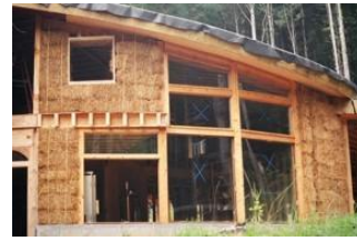
شكل (٢-٣٦٠) الهيكل الخشبي الدائري بعد وضع البالات لعمل الحوائط
