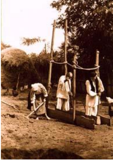
شكل ( ٣-٥٤٨ ) استخدام يدوي لدك التربة
