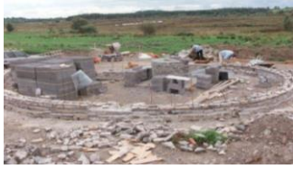
شكل (٢-٤٠٧) الأساسات الحجرية للمبنى
