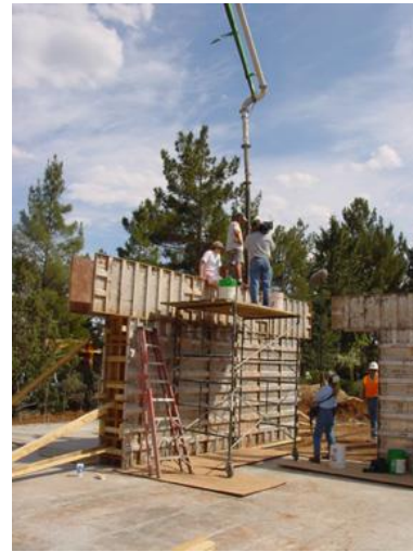
شكل (٢-١٦٥) صب الحوائط بطريقة حديثة باستخدام الميكنة
