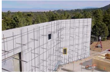
شكل (٢-١٦٤) استخدام شدات بارتفاع الحائط - دعامات لتقوية الحائط
