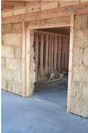
شكل (٢-٥١٩) إطار الباب الخارجي قبل التشطيب
