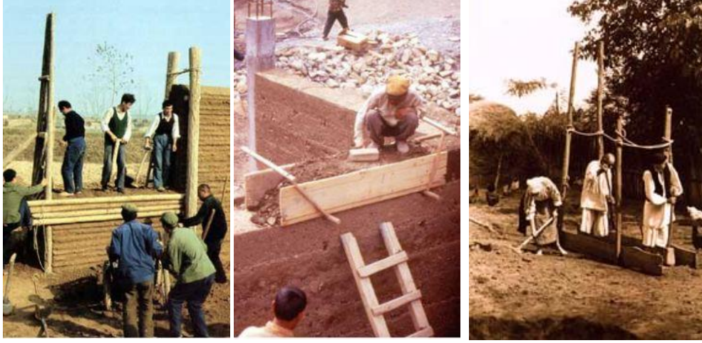
شكل (٢-١٩١) استخدام يدوي لدك التربة شكل (٢-١٩٢) شدة خشبية بسيطة- شكل (٢-١٩٣) شدة خشبية - الصين أفريقيا الهند
