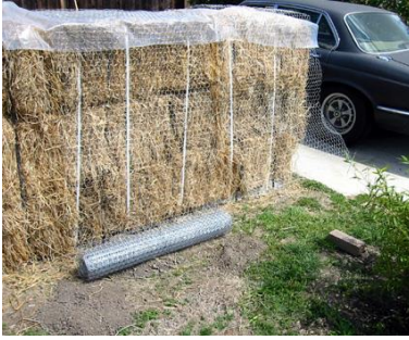
شكل (٢-٣٨٧) الحائط بعد وضع العازل من البلاستيك فوقه ثم وضع الشبك المعدني لسهولة التشطيب
