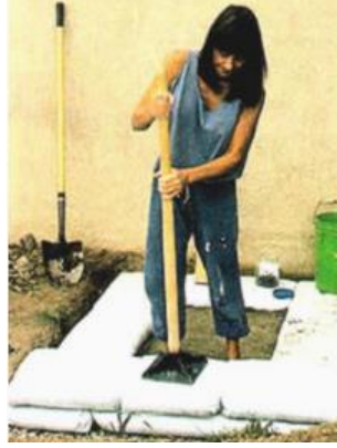
شكل (٢-٢٦٦) استخدام مدك يدويا لدك الأكياس
