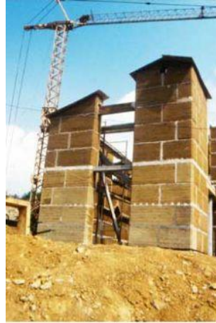
شكل (٢-٢١٤) فرنسا - منزل باستخدام الوحدات سابقة الدك- شدة معدنية لعمل الحائط
