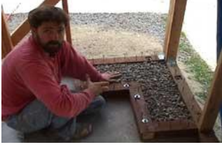
شكل (٢-٣٤٨) أساس لتثبيت البالات في هيكل إنشائي خشبي
