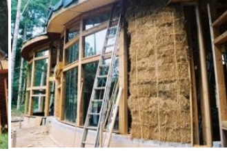
شكل (٢-٤٢٢) حوائط دائرية بعد وضع البالات داخل الهيكل الخشبي
