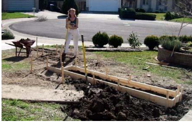
شكل (٢-٣٧٥) الحفر وعمل شدة من الخشب لصب الأساس
