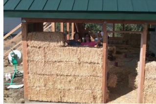
شكل (٢-٣٥٣) وضع البالات في الهيكل مع مراعاة فصل اللحامات
