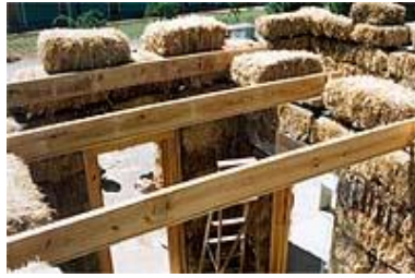
شكل (٢-٤٩٤) وضع العوارض الخشبية لإنشاء السقف
