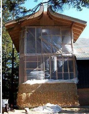
شكل (٢-٤٢٢) حوائط دائرية بعد وضع البالات داخل الهيكل الخشبي
