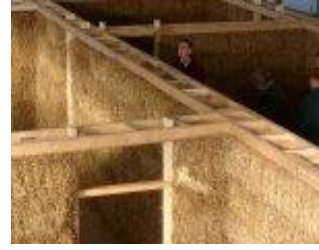
شكل (٢-٣٥٥) تقاطع الحوائط الداخلية وتثبيتها من أعلى الحائط
