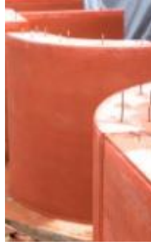
شكل (٣-٦٣٧) الحوائط بعد ازالة الشدات
