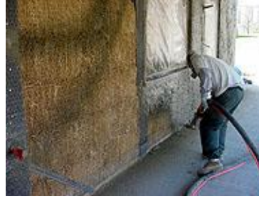
شكل (٢-٤٤٩) وضع أول طبقة تشطيب للحائط مع وجود شبك ممد عن طريق الضخ
