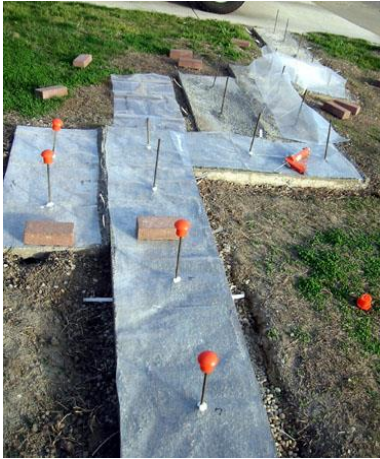
شكل (٢-٣٨٠) من خطوات العزل يتم وضع عازل علي الاساسات
