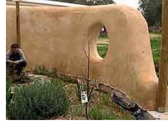
شكل (٢-٣٩٣) حائط من القش به فتحة دائرية قبل وبعد التشطيب تم وضع شبك معدني على الحائط لسهولة التشطيب
