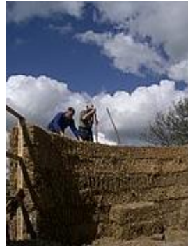
شكل (٢-٤٠٤) تثبيت المدماك الأخير بقضيب خشبي
