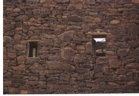
شكل (١-٩٦) جدار من الحجر المبني بدون لاصق أو مونة ( عسير )
