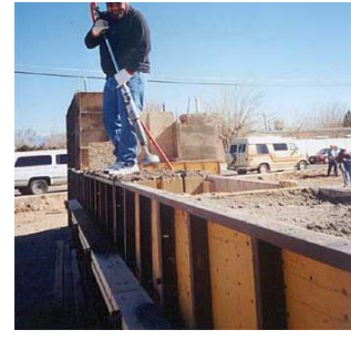
شكل (٣-٥٧٧) الشدات بارتفاعات مختلفة لعمل الحائط
