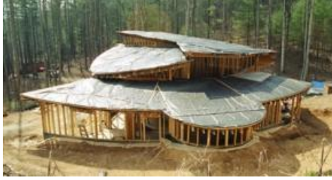
شكل (٢-٣٥٩) هيكل المبنى الخشبي مكون من لحوائط دائرية للمبنى قبل وضع البالات
