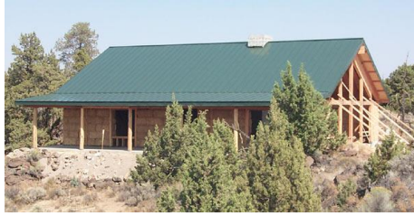
شكل (٢-٥٠٣) الهيكل الإنشائي الخشبي للمنزل
