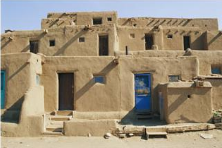
شكل (٣-٤٩) استخدام الطفلة في البناء - اليمن
