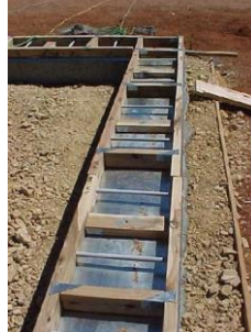
شكل (٢-٤٥٤) الأساسات للحوائط الحاملة لقش الأرز
