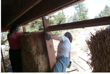
شكل (٢-٥٢٦) تثبيت البالات داخل الهيكل الخشبي
