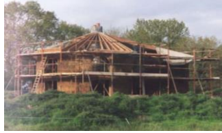
شكل (٢-٤٠٨) المبنى من الخارج والشدات الدائرية
