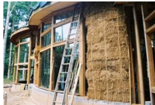
شكل (٢-٣٦٠) الهيكل الخشبي الدائري بعد وضع البالات لعمل الحوائط
