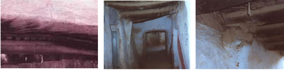
شكل (٣-٥١) استخدام الأشجار في التسقيف في سيوة
