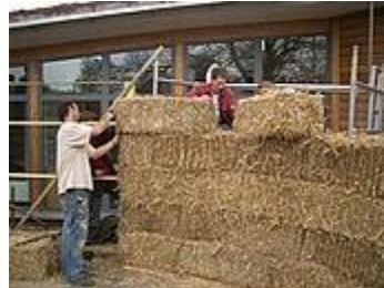
شكل (٢-٤٠٥) الحائط وعدم تطابق اللحامات
