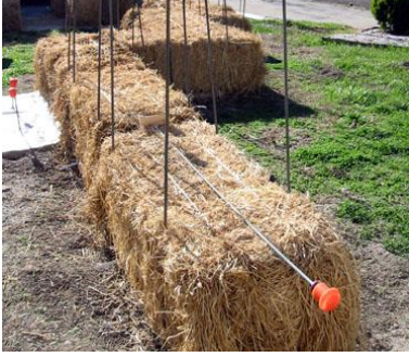
شكل (٢-٣٨٢) الدعامات الرأسية والأفقية الجانبية للحائط من المعدن
