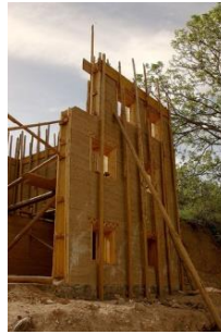
شكل (٣-٥٧٧) الشدات بارتفاعات مختلفة لعمل الحائط
