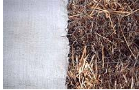
شكل (٢-٤٩٨) جزء من الحائط تم التشطيب وجزء قبل التشطيب
