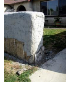
شكل (٢-٣٨٨) خطوات وضع التشطيب علي الحائط بوضع الطبقة الأولى
