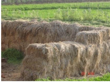
شكل (٢-٣٢٢) فراغ تم استخدام البالات في عمل الحوائط - مصر
