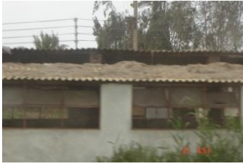
شكل (٢-٥٤٤) استخدام القش في تغطية الاسقف
