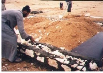
شكل (١-٥٨) استخدام الاحجار الاساسات - معمل - بلبيس
