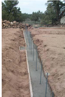
شكل (٢-٥٠٦) الأساسات بعد صب الخرسانة ووضع قضبان من الحديد
