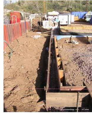
شكل (٢-٣٦٦) شدة خشبية لصب الأساس الخرساني
