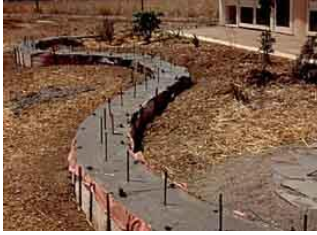
شكل (٢-٣٩٤) الأساسات المنحنية وأسيخ مثبتة بها لتثبيت المدمك الأول
