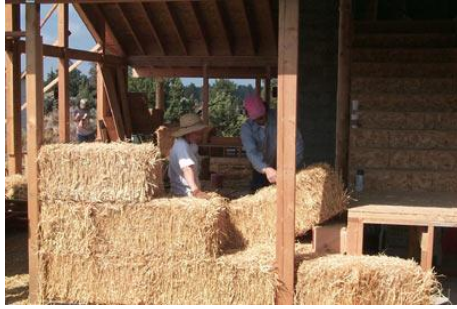
شكل (٢-٥٢٨) عدم تطابق اللحامات للبالات
