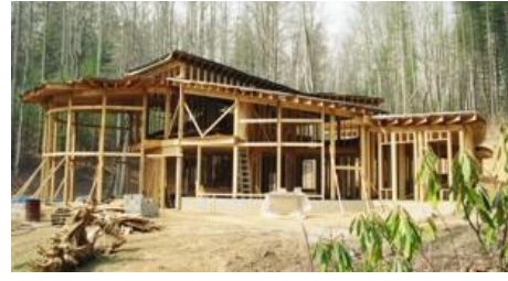
شكل (٢-٣٥٨) الإنشاء الهيكلي من الخشب للمبنى من الخارج
