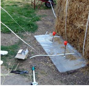
شكل (٢-٣٨٤) خيوط بلاستيكية لربط الباله تثبت في الأساس عند صبها وترتبط من أعلي
