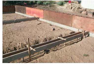
شكل (٢-٥٠٥) أساس الحوائط الداخلية
