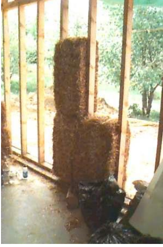
شكل (٢-٣٥١) هيكل إنشائي خشبي تم وضع البالات راسية
