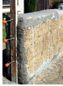
شكل (٢-٣٨٨) خطوات وضع التشطيب علي الحائط بوضع الطبقة الأولى
