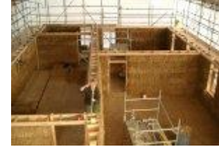
شكل (٢-٤٥٢) الحوائط الداخلية غير حاملة للسقف
