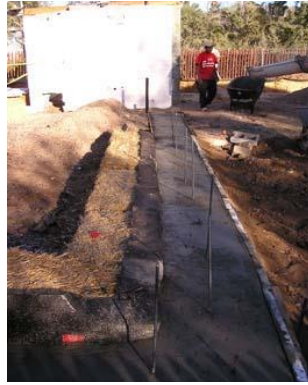
شكل (٢-٣٦٧) صب الخرسانة مع وضع اسياخ حديدية لتثبيت البالات
