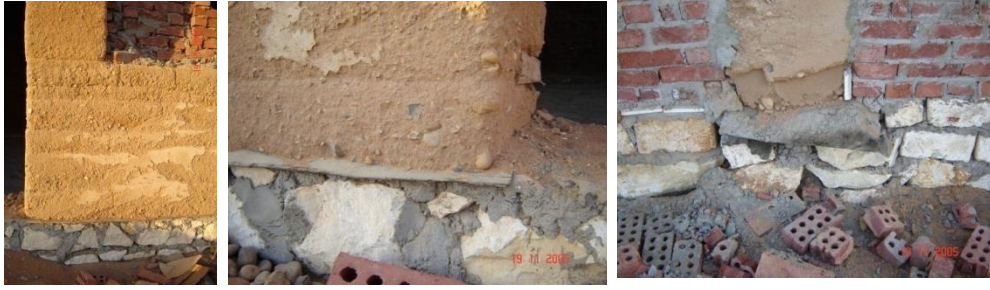
شكل (٣-٦٦٤) الطبقة العازلة والحائط ارتفاع الحائط عن الأرض
