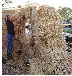
شكل (٢-٣٩٣) حائط من القش به فتحة دائرية قبل وبعد التشطيب تم وضع شبك معدني على الحائط لسهولة التشطيب
