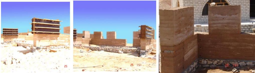
شكل (٣-٦٦٣) الحائط والشدات مثبتة على الحائط - تحديد اماكن الفتحات
