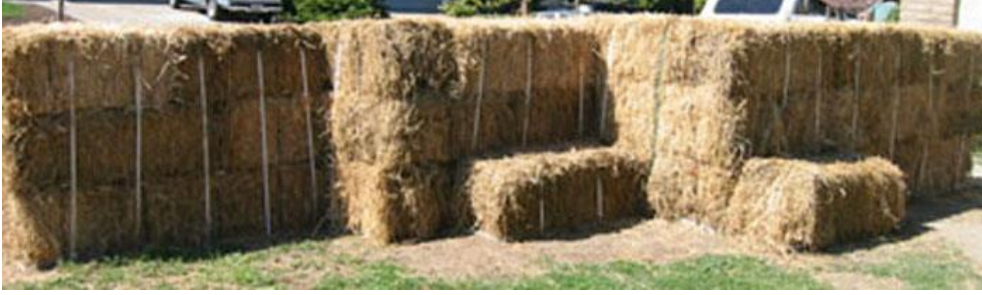
شكل (٢-٣٨٦) الحائط بعد ربطه بالخيوط البلاستيكية وتثبيتها من أعلى البالات مع وضع أماكن للجلوس ملاصقة للجدار
