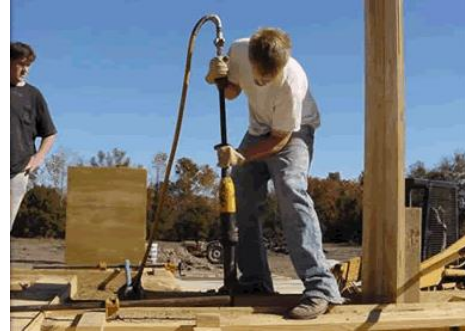
شكل (٢-١٩٨) مدك آلي لدك التربة بالميكنة
