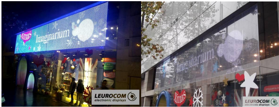
شكل (٢-٤٦) وحدات زجاجية باعثة للضوء نهاراً وليلاً وإستخدامها في Madrid, Spain المصدر: http://www.core77.com/blog/architecture.com
