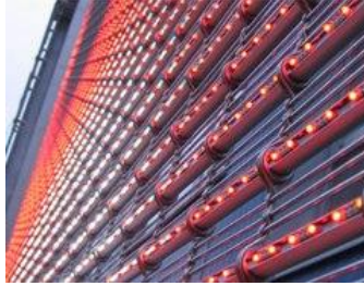
شكل (٤٨-٢) شبكة الواجهة الإعلامية محملة بوحدات LED المصدر: http://gkd.uk.com/home/creativeweave/newproducts/mediamesh
