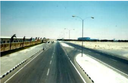
صورة ٧-١٦: توضح شبكات الطرق المنفذة ببني سويف الجديدة ، المصدر : هيئة المجتمعات العمرانية الجديدة - بني سويف الجديدة.
