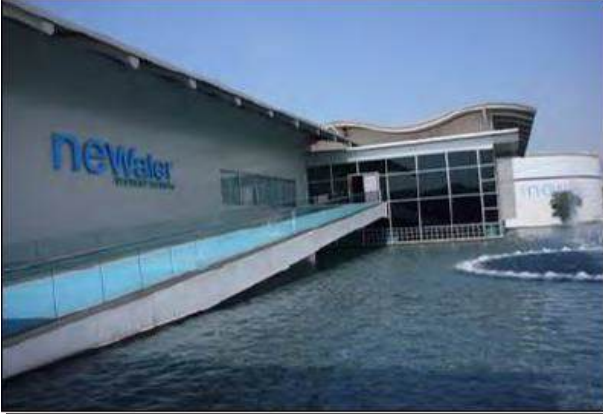
صورة ٦-٣٠: توضح احد مصانع معالجة المياه في سنغافورة،المصدر:
