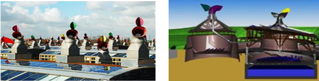
شكل (٢-٩): قطاع بالباديكير المستخدم للتهوية فوق المنازل،المصدر: https://www.tboake.com/gallery/bedzed.html
